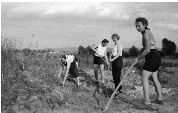
1947 Beseitigung der Bombentrichter zur Vorbereitung des Grundstückes, allerdings konnte erst 1960 das Bootshaus errichtet werden
